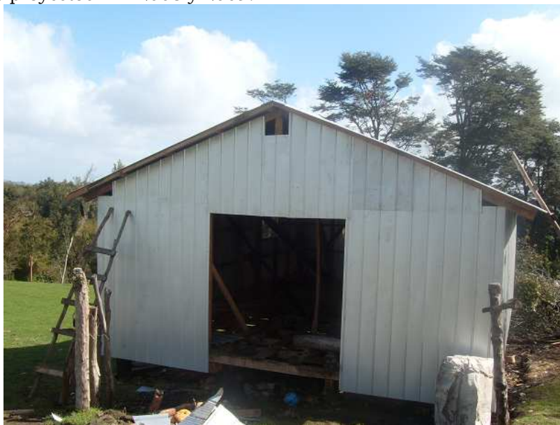
PDI, Galpón ovino en construcción
